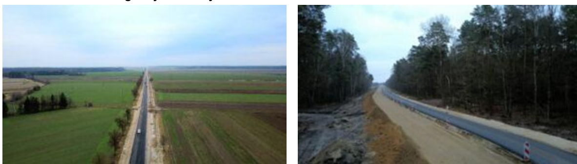
Fot. 10 Rozbudowa drogi wojewódzkiej Nr 812 na odcinku Żuków – Korolówka
