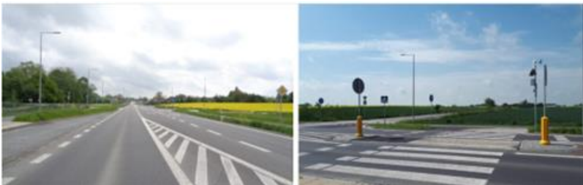
Fot. 24 Rozbudowa drogi wojewódzkiej Nr 835
