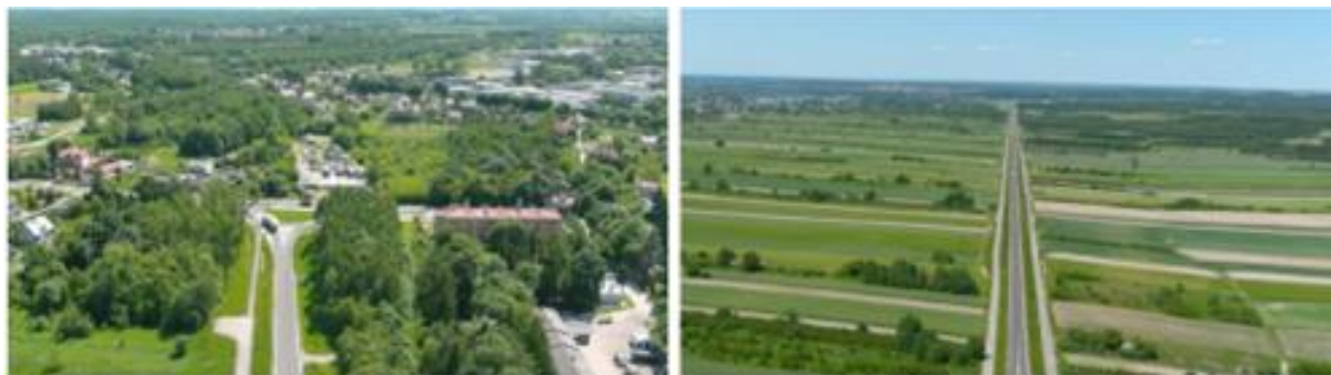
Fot. 23 Rozbudowa drogi wojewódzkiej Nr 833 Chodel – Kraśnik
