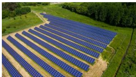
Fot. 33 Elektrownia fotowoltaiczna o mocy 900 kW w miejscowości Lubyca Królewska
