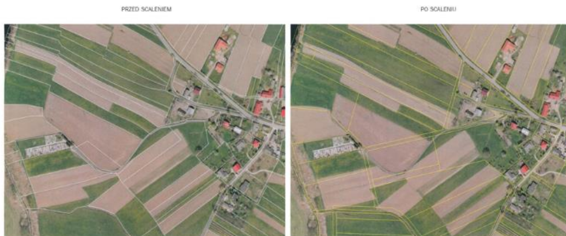
Fot. 30 Scalanie gruntów realizowane w ramach poddziałania Wsparcie na inwestycje związane z rozwojem modernizacją i dostosowaniem rolnictwa i leśnictwa objętego Programem Rozwoju Obszarów Wiejskich
