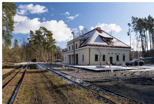
Fot. 16 Stacja Kultura - rewitalizacja budynku i otoczenia dawnej stacji kolejki wąskotorowej w Poniatowej
