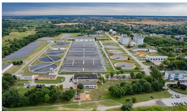
Fot. 11 Oczyszczalnia Ścieków Hajdów położona we wschodniej części miasta Lublina
